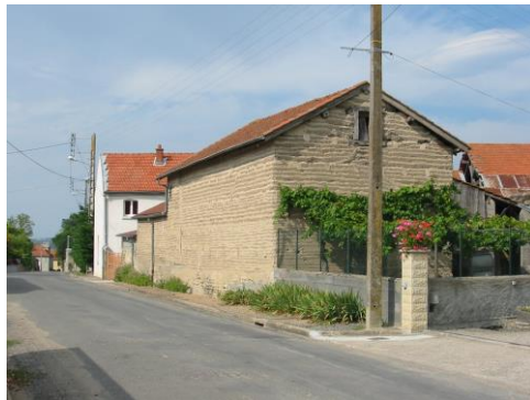
Construction en pisé
