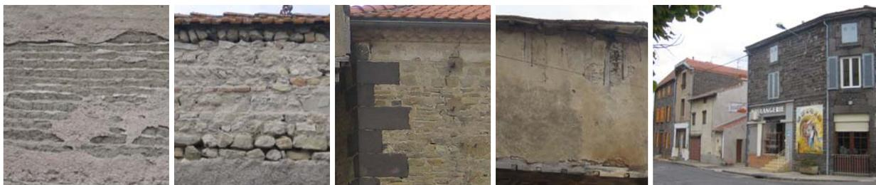
Pisé / Moellons de roches marneuses / Chainage en Volvic / Pan de bois / Constructions en roches volcaniques
