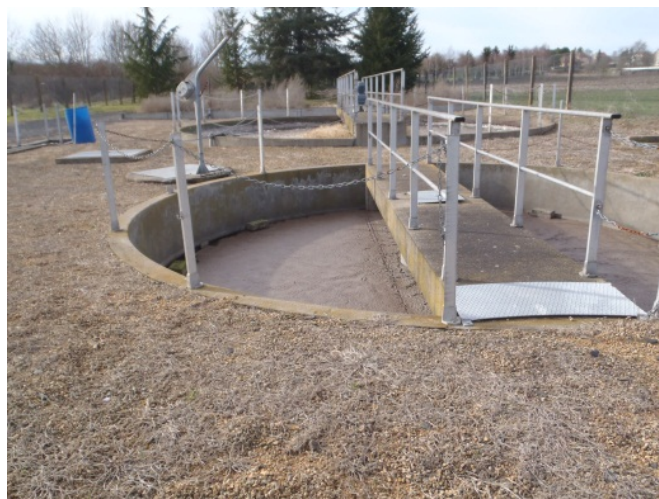
Croûte de boues dans le clarificateur
